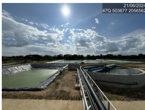
รูปที่ 2-9 ระบบรวบรวมน้ำเสียของโครงการ
