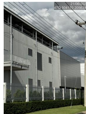
รูปที่ 2-2 ก่อสร้างอาคารด้วยวัสดุดูดซับเสียง
