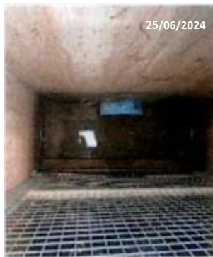
รูปที่ 2-5 บ่อตรวจคุณสมบัติน้ำเสีย (Inspection Manhole)
